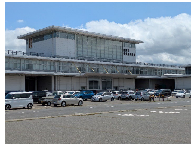
【市場本棟（中央棟）】
